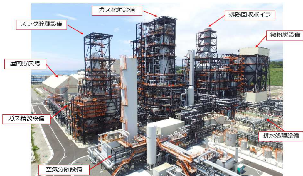
② 発電所全景写真(各設備名称なし)
